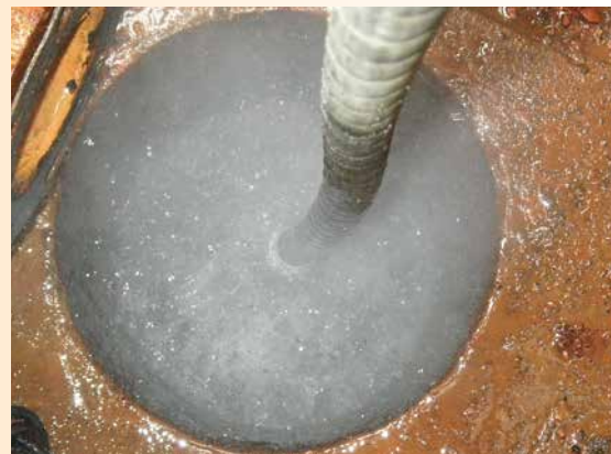
施工状況 2（仕上げ用）
