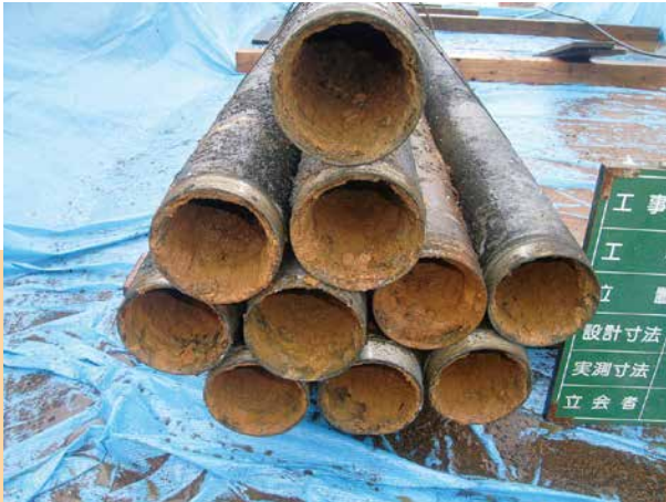
施工前揚水管内状況
