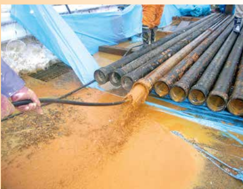
揚水管内洗淨状況
