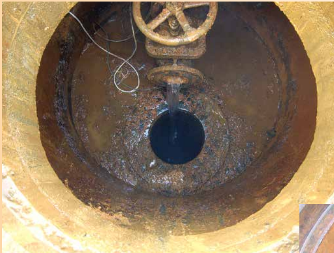
施工前ピット内状況
