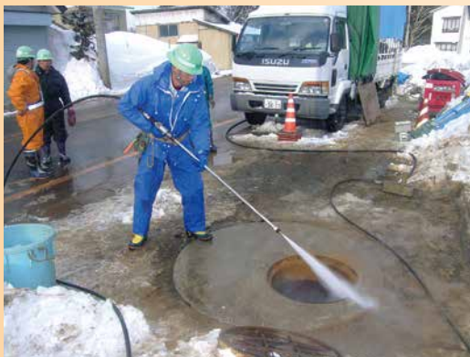
ピット洗浄作業状況
