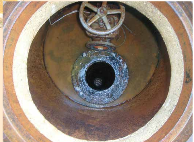
ピット洗浄施工後
